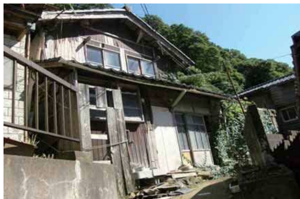
▲除却された危険老朽空き家
