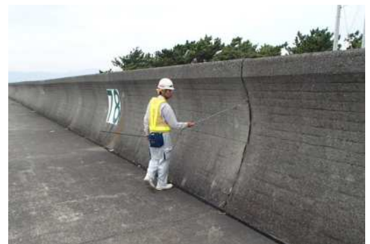
＜打音調査状況＞
