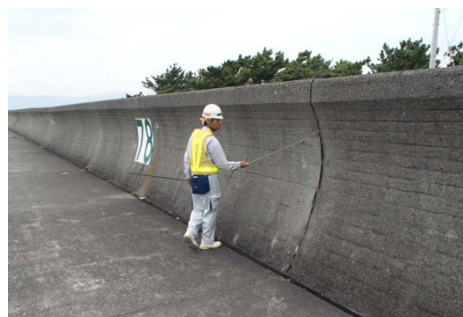
<打音調査状況>
