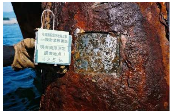
肉厚測定箇所（ケレン処理後）
