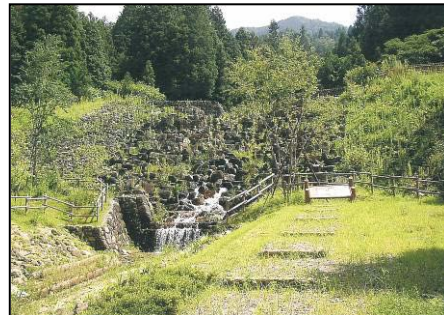
砂防えん堤の再整備
