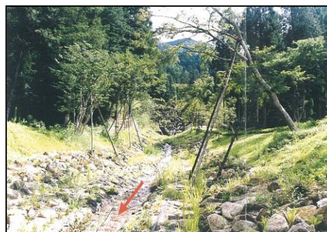
自然にやさしい溪流保全工
