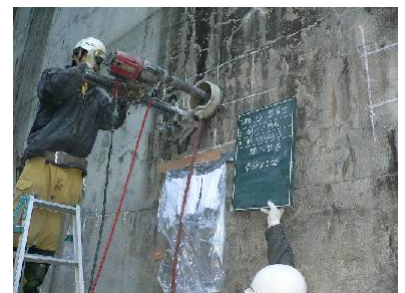
ひび割れ調査の実施状況
