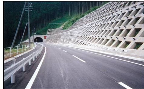
フリーフレーム・アンカー工
